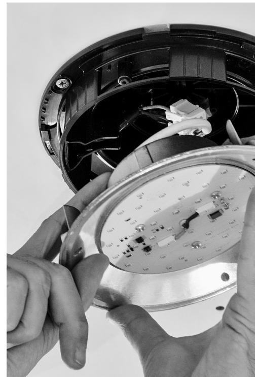
**SK** Uložte káble do medzipriestoru v strede svietidla. Dabajte na to, aby bol deflektor správne orientovaný voči skeletu.
